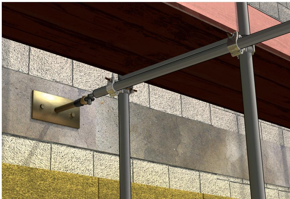
Bild 11: Beispiel für einen Daueranker
