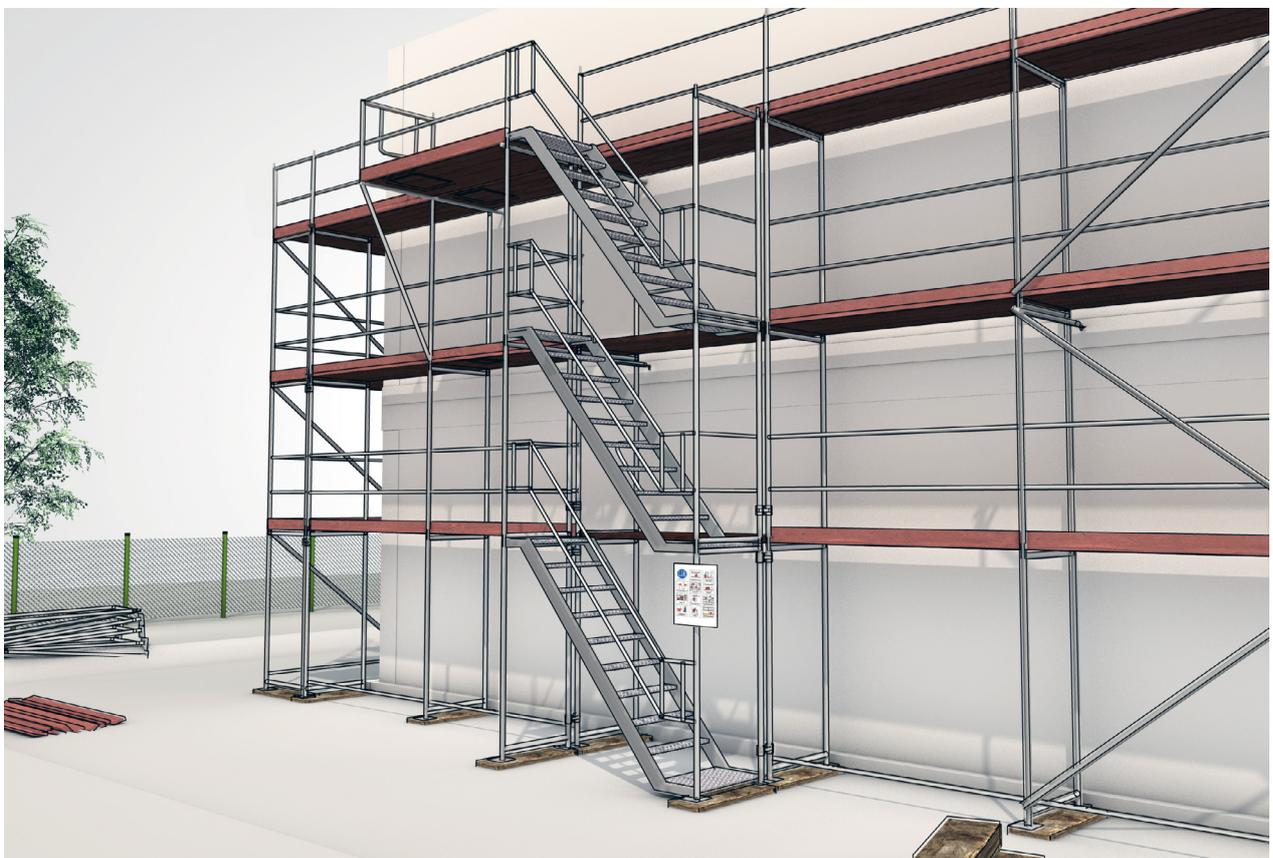
Bild 8: Gerüst mit Gerüsttreppe als Zugang
